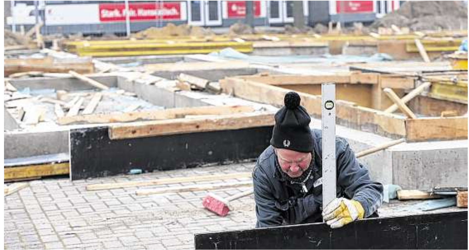
Derzeit wird auf dem Bauplatz hinter der Wendeschleife der Linie 4 mit Hochdruck gearbeitet.
